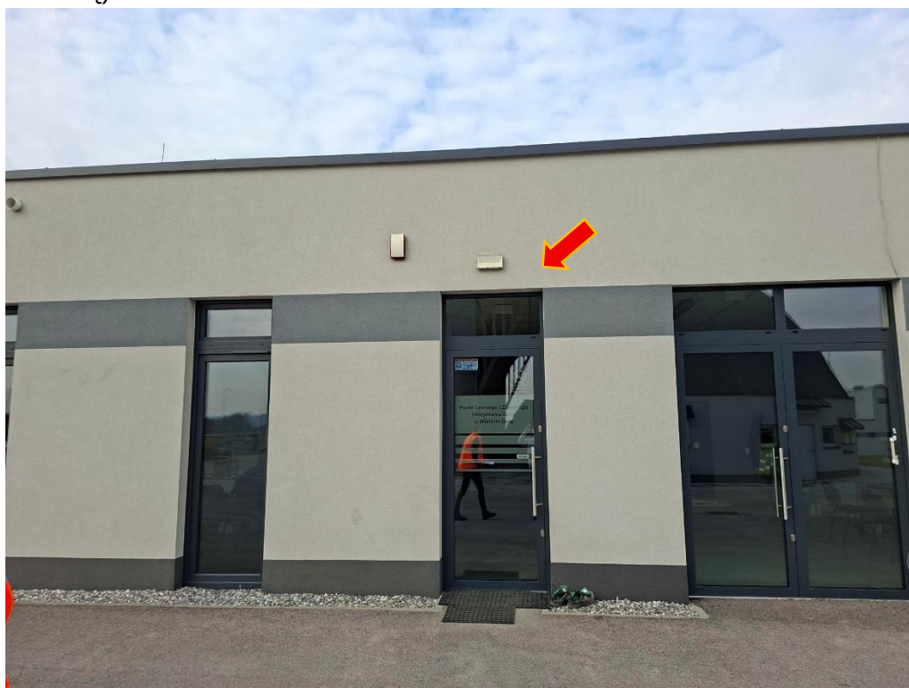
Zdj.3. Wejście do budynku warsztatowo-garażowego (miejsce montażu wskazane strzałką)
