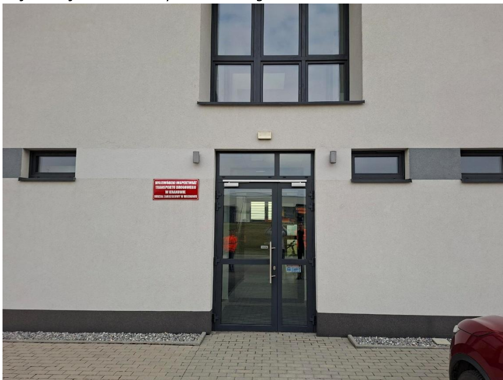
Zdj.2. Wejście B do budynku biurowego
